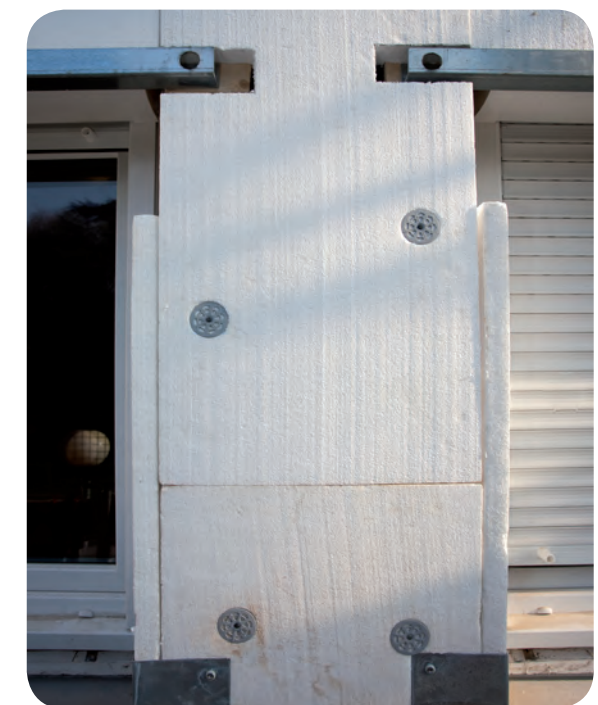
Retours d'isolant sur menuiseries
